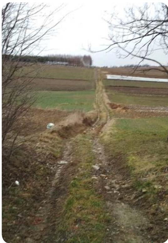
Ulica Szlak przed modernizacją
