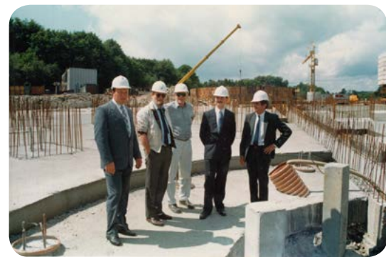
Dania. Budowa oczyszczalni.
